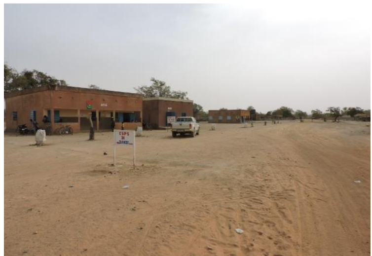
Figure 16: Vue du CSPPS de Dandé et sa contiguïté avec la route Dandé-Djuinguima
